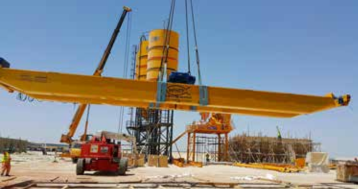
Costruzione di dighe - Construction of dikes
