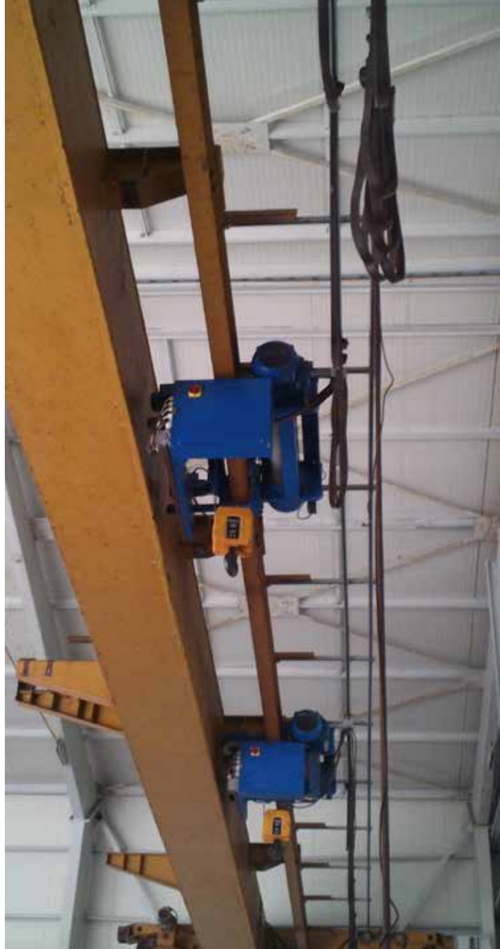
Impianto di zincatura - Galvanizing plant
